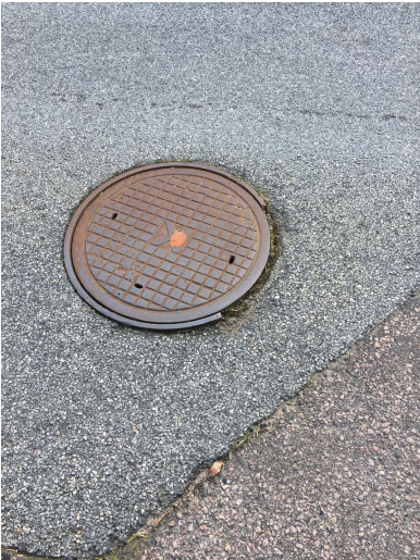
Nya brunnslöck Hagvägen Kostnad av Gbg kommun
